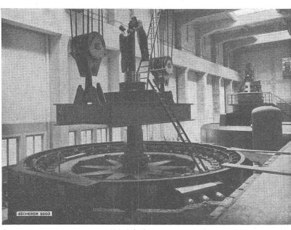
Der Rotor eines der Verbois-Grossgeneratoren wird montlert. Radstern, Radkranz und Pole sind gut sichtbar
