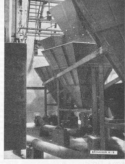
Abb. 4. Trichterförmige feste Boden-Elektroden
