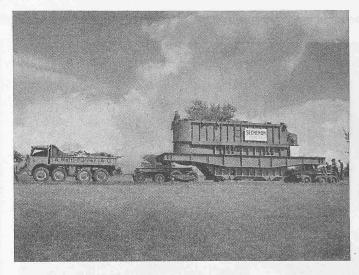
Abb. 2. Landstrassen-Transport eines Transformators von Sécheron nach dem Kraftwerk Verbois auf einem Landtransportwagen mit 50 Reifen und einem Traktor durch die Welti-Furrer A.-G.
