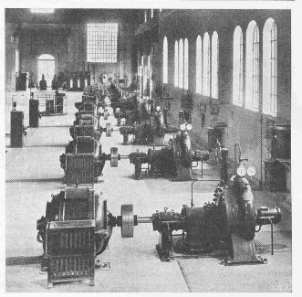
Abb. 11. Wasserversorgungsanlage einer grossen Stadt in Frankreich Im Vordergrund fünf Mitteldruck-Sulzer-Zentrifugalpumpen von je 355 l/s Fördermenge auf 62 m Förderhöhe
