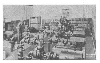
Vollautomatische Pumpstation, ausgerüstet mit fünf Combi-Motoren
