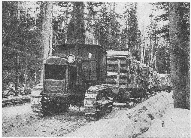
Abb. 5. Raupenschlepper mit Schlitten für Papierholztransport (U.S.A.)
