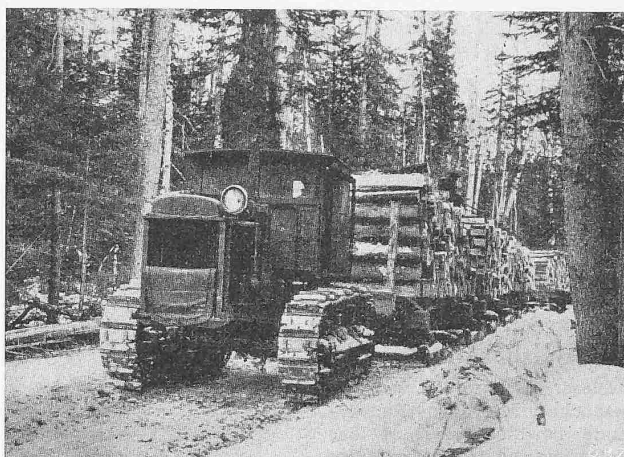
Abb. 5. Raupenschlepper mit Schlitten für Papierholztransport (U.S.A.)
