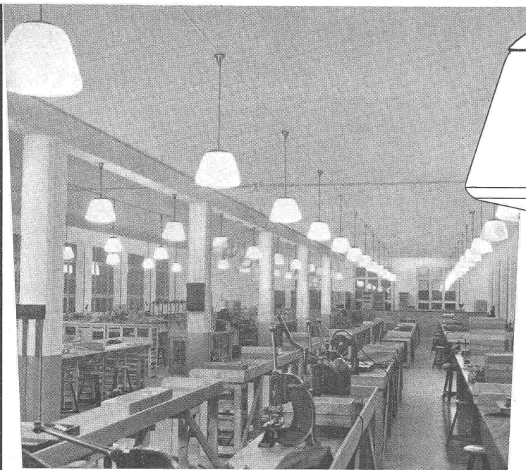
Beleuchtung eines Fabriksaales mittels Mischlichtlampen
