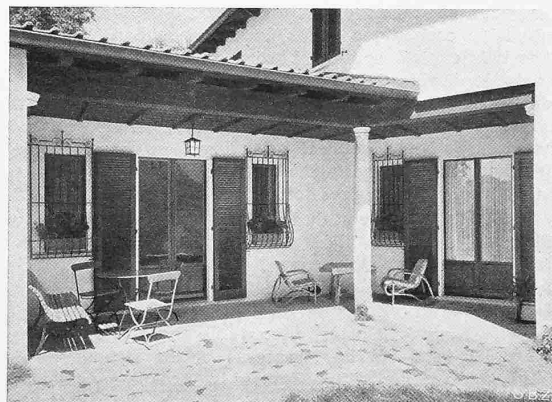
Abb. 5. Loggia-Ecke vor der Halle
