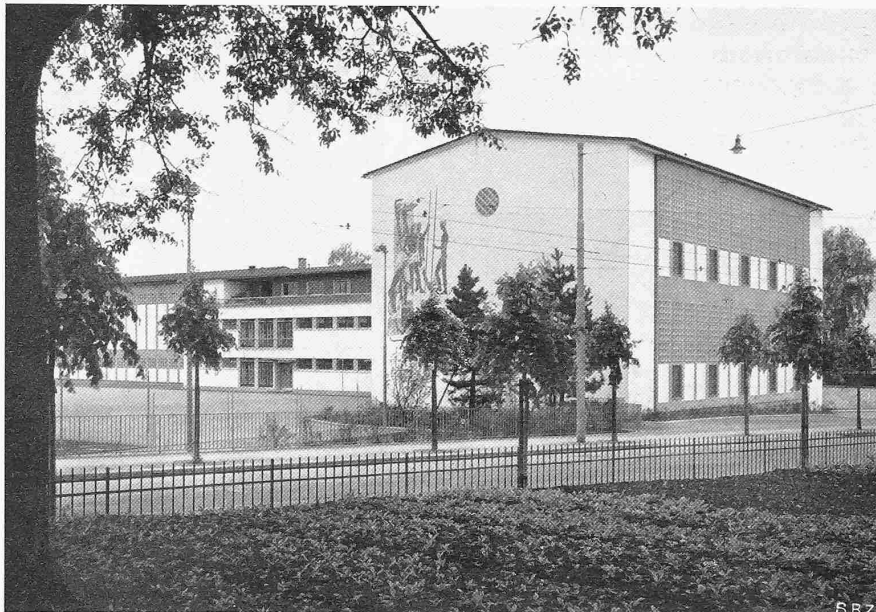
Abb. 3. Ansicht aus Norden, von der Gloriastrasse aus
