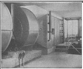
Konditionierungsaggregat zur Klimaanlage
