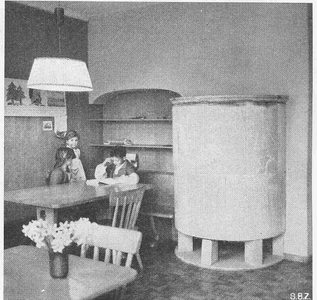
Abb. 11. Kinderzimmer im Erdgeschoss-Westflügel
