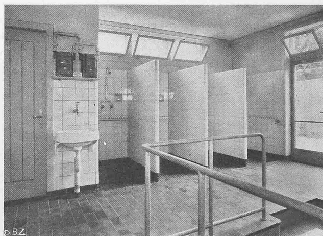
Abb. 6. Douchenraum, links Gas-Warmwasser-Automaten
