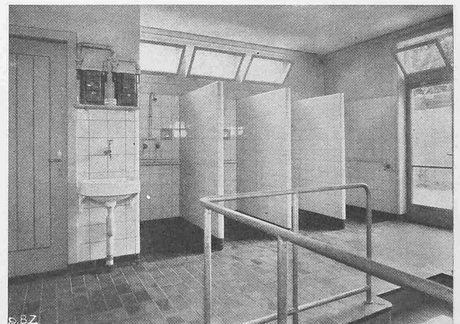
Abb. 6. Douchenraum, links Gas-Warmwasser-Automaten
