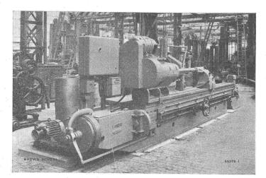
Landis-Zylinderschielfmaschine nach Modernisierung des Antriebes, d. h. Aufteilung des Transmissionsantriebes in fünf Einzelantriebe.
