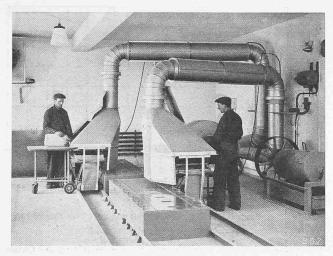
Abb. 3. Sieberei mit Staubabsaugeinrichtung
