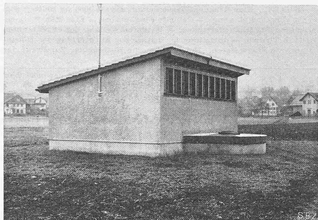
Abb. 3. Pumpengebäude mit angebautem Sammelbrunnen
