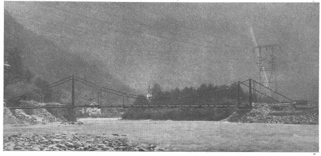
Hängebrücke 35,7 m Spannweite
