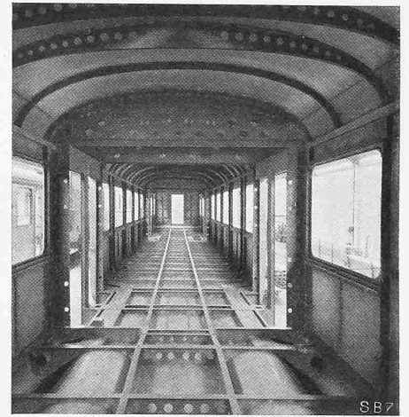
Abb. 9. Inneres des Kastenträgers
