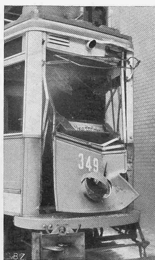
Abb. 2. Holzgerippe-Wagen nach Zusammenstoss unter ähnlichen Verhältnissen
