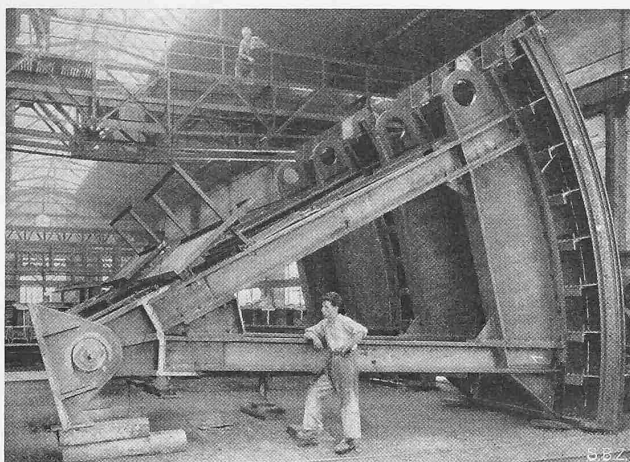
Abb. 1. Zwei Sektorschützen für Grundabstollen bei Lima (Peru) (im Werk Döttingen). Öffnungen 3,0 \times 3,8 m, Stauhöhe 83 m
