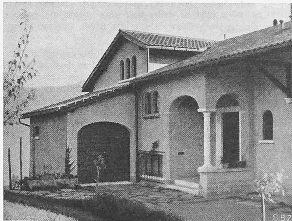
Abb. 3. Haupteingang und Garage an der Nordseite
