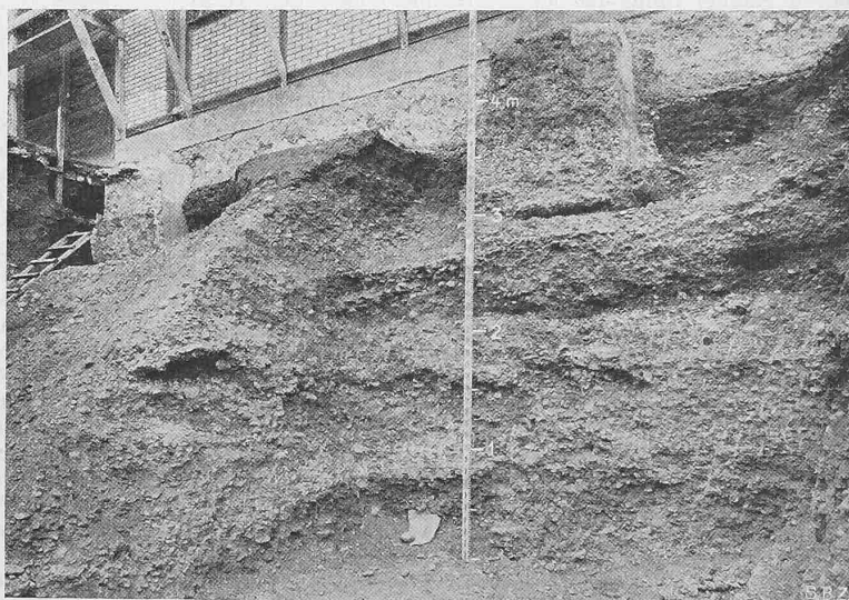
Abb. 2. Freigelegter, auf 5 1/2 m Tiefe durch Zementinjektionen verfestigter Boden
