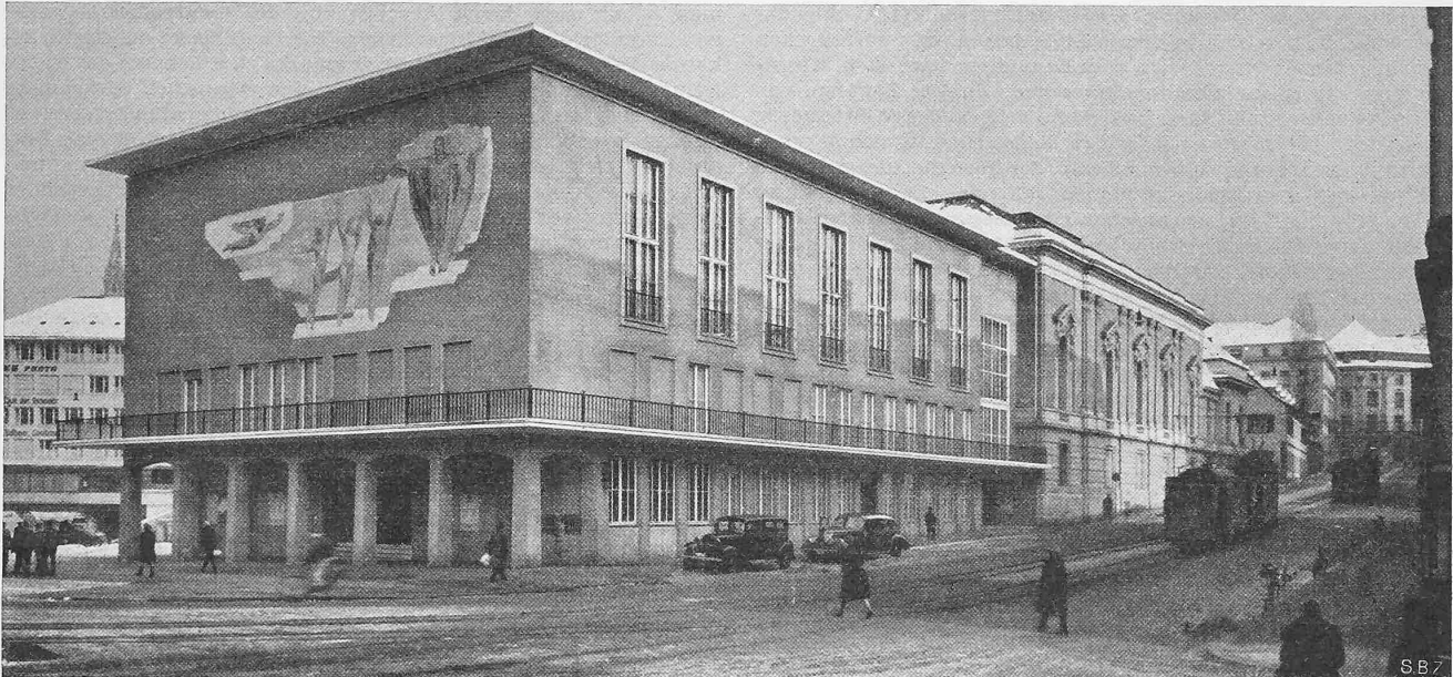
Abb. 4. Neubau Casino (mit Pellegrini-Fresco). Architekten W. KEHLSTADT, W. BRODTBECK, BRÄUNING, LEU, DÜRIG. Rechts Musiksaal
