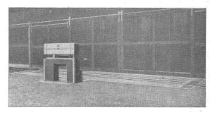
40 t Geleisewaage mit armierter Betonbrücke, torsionsfreien Hebeln und verstellbaren Schneiden.
