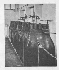
Abb. 1. Form und Abmessungen 1:30 und Abb. 2 Ansicht der sechs Methangas-Stahlgussbehälter Bauart Sulzer für 1,1 m³ unter 350 atü
