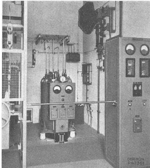
Diese luftgekühlte Gleichrichteranlage einer schweizerischen Nebenbahn hat eine Leistung von 500 kW bei 900 V. Der Gleichrichter ist überlastbar mit 50 % während zwei Stunden, mit 100 % während einer Minute und mit 200 % während 10 Sekunden. — Die komplette Anlage konnte im unteren Teil einer schon bestehenden Transformatorenstation (Abbildung links) auf nur 4 x 4 m Bodenfläche eingebaut werden.
