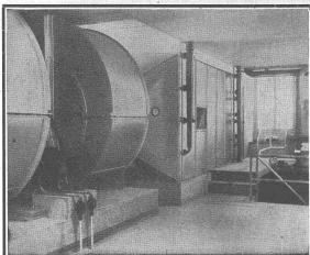
Konditionierungsaggregat zur Klimaanlage
