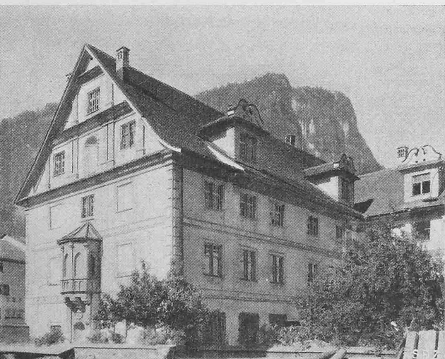
Abb. 5. Südgiebel mit Kapellen-Erker (alter Zustand)
