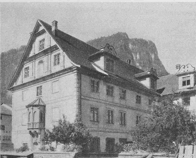
Abb. 5. Südgiebel mit Kapellen-Erker (alter Zustand)
