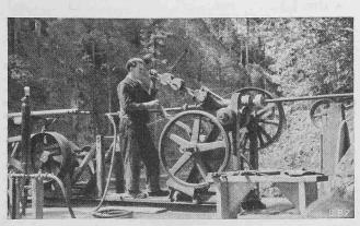
Abb. 2. Rotationskernbohrmaschine bei Horizontalbohrung
