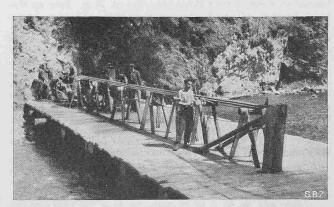
Abb. 8. Gestänge-Lagerung und -Führung für 160 m Horizontalbohrung
