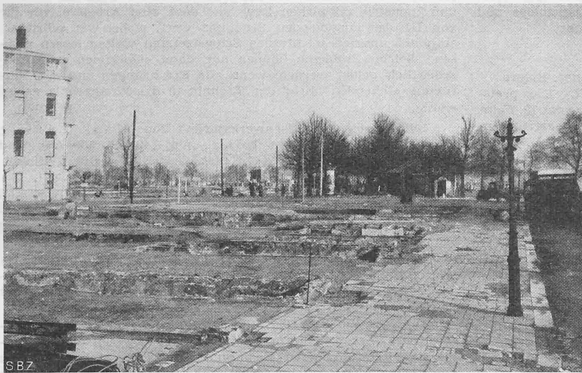
Abb. 13. Teilansicht des am 14. Mai 1940 niedergelegten Stadtkerns von Rotterdam. Aufnahme vom September 1940
