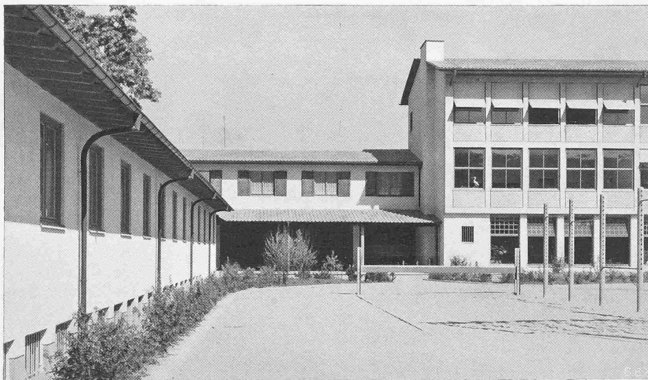
Abb. 4. Turnhalle, Abwartwohnung (darunter offene Halle) und Schulhaus
