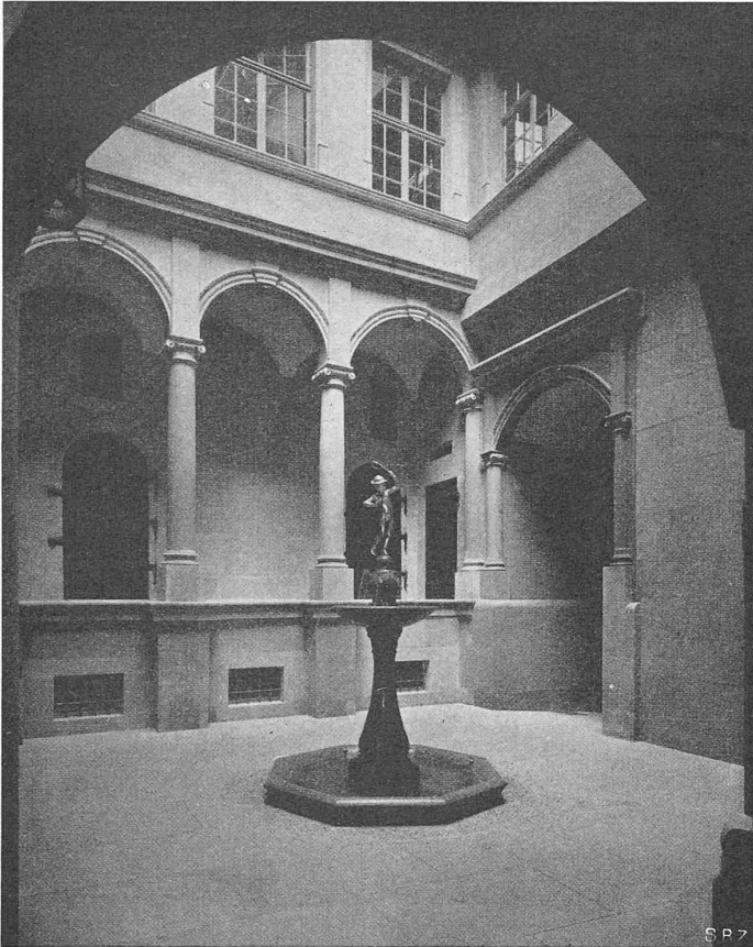
Abb. 11. Renaissance-Hof zwischen Rathaus und Staatskanzlei
