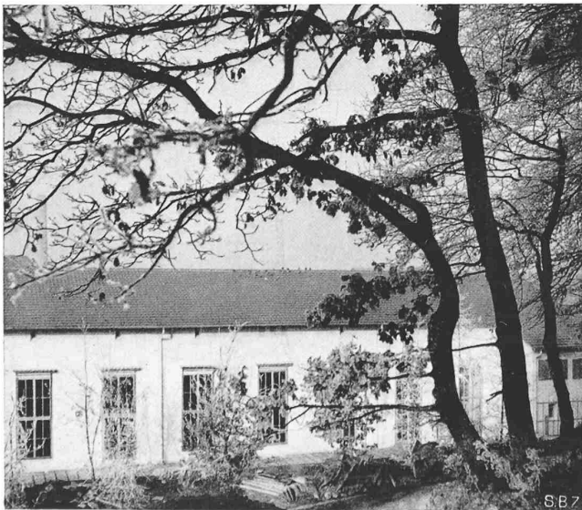
Abb. 4. Teilansicht der Südfront
