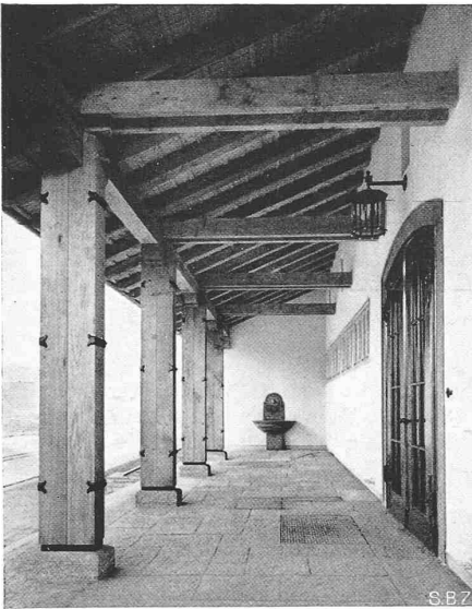
Abb. 3. Vorhalle in Eiche mit Eisenbeschlägen
