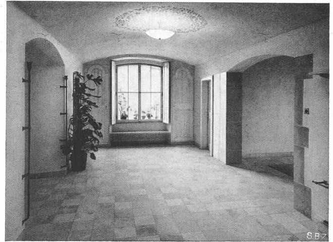
Abb. 12. Eingangshalle, Boden Solnhoferplatten
