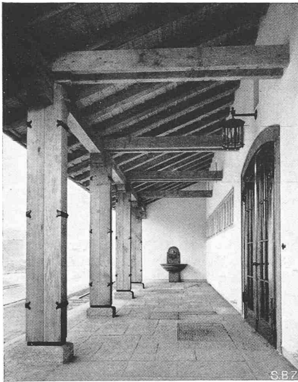
Abb. 3. Vorhalle in Eiche mit Eisenbeschlägen
