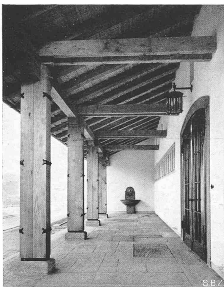
Abb. 3. Vorhalle in Eiche mit Eisenbeschlägen
