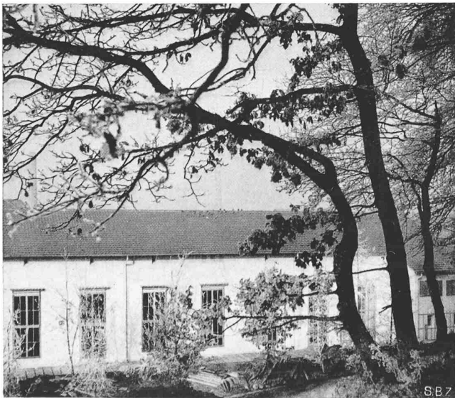
Abb. 4. Teilansicht der Südfront
