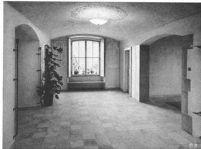
Abb. 12. Eingangshalle, Boden Solnhoferplatten
