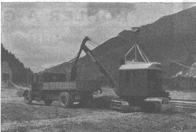
Bagger mit Elektro-Antrieb
