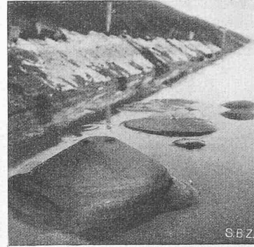
Abb. 4. Wasser-, Schlamm- u. Sandaufstösse
