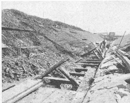
Abb. 3. Zerdrückter Sohleneinbau
