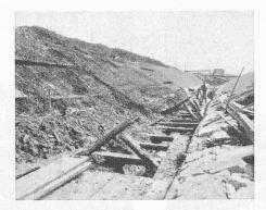
Abb. 3. Zerdrückter Sohleneinbau
