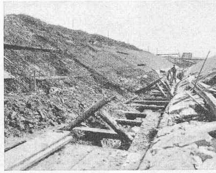
Abb. 3. Zerdrückter Sohleneinbau
