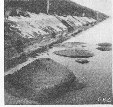
Abb. 4. Wasser-, Schlamm- u. Sandaufstösse
