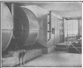
Konditionierungsaggregat zur Klimaanlage
