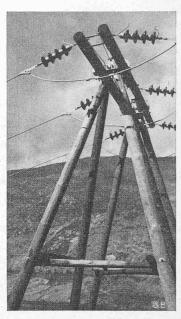
Abb. 35. Abspann- und Winkelmast
