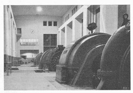
Abb. 30. Der Maschinensaal des Kraftwerks Mörel. Drei Gruppen zu je 24 900 PS
