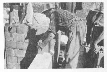
Abb. 1. Versetzen der Novadom-Ziegel auf Perfekta-Platten
