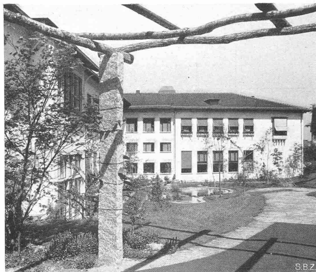
Abb. 3. Wohlfahrtshaus der SWO, Ansicht aus Südwest
