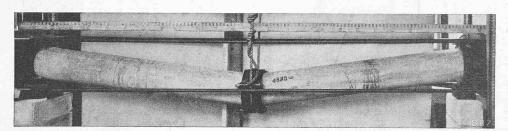
Abb. 23. Biegeversuche gekuppelter Rohre unter Innendruck
