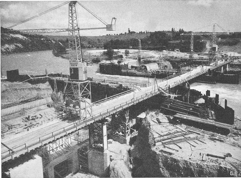
Abb. 6. I. Bauphase: links Maschinenhaus-Baugrube, rechts Wehr-Baugrube
