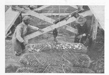
Abb. 8. Einbau der Drahtgeflecht-Senkwalzen
