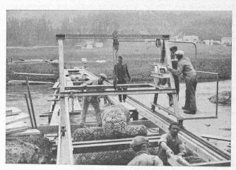
Abb. 9. Transport und Einbau der Senkwalzen
