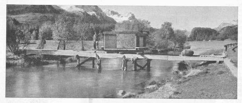
Abb. 10. Provisorisches Stauwehr am Silsersee-Ausfluss, im Bau
