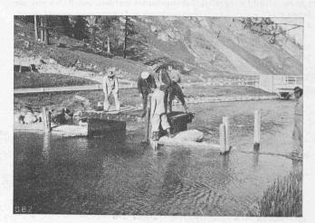
Abb. 7. Provisorischer Stauabschluss, Oberwasserseite
