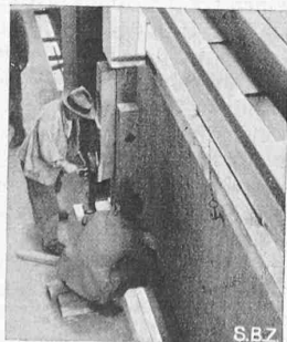
Abb. 5. Hebeklotz, Arretierklotz und Winde
