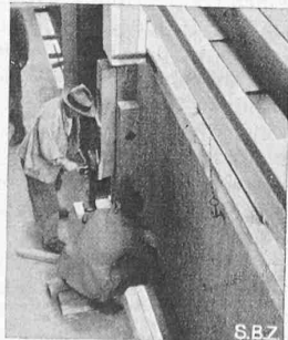
Abb. 5. Hebeklotz, Arretierklotz und Winde
