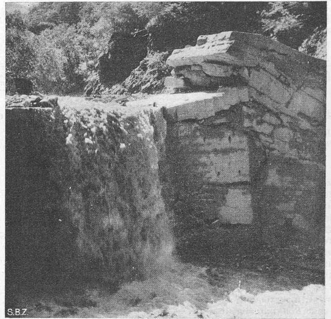
Abb. 1. Nolla-Sperre III unter Einwirkung des Bergdruckes von rechts, Aufnahme 1939
