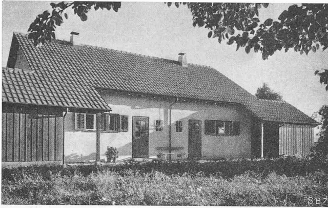
Abb. 9. Bergseite Architekt H. NINCK, Winterthur
