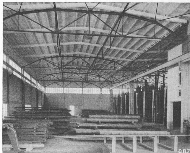
Abb. 6. Innenaussicht der Halle 1, rechts hinten Halle 2
