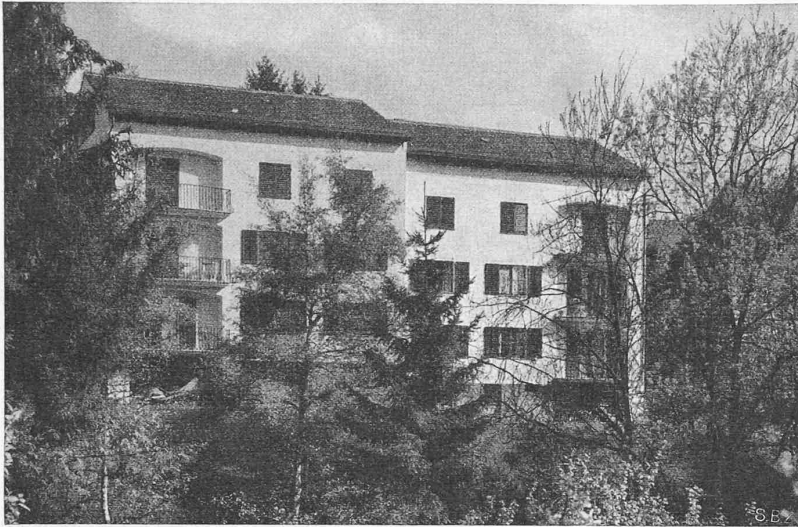
Abb. 3. Doppel-Mehrfamilienhaus, Talseite. — Arch. A. JENNY, Zürich
