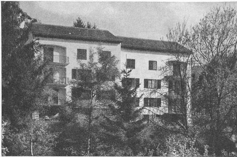
Abb. 3. Doppel-Mehrfamilienhaus, Talseite. — Arch. A. JENNY, Zürich
