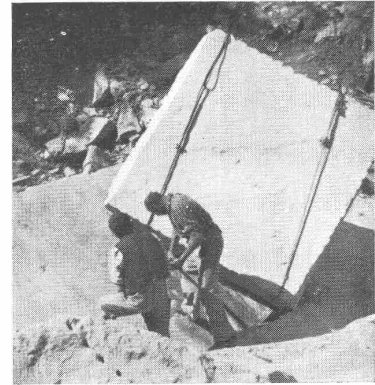
Bild: Hebung einer Podestplatte für die Wasserkirche. Gewicht im Rohzustand ca. 5500 kg.
