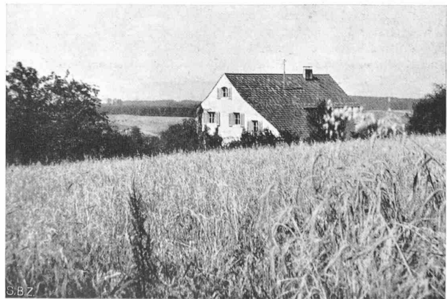
Abb. 9. Das Haus im Gelände, aus Osten
