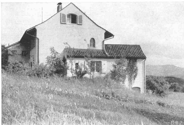
Abb. 8. Nordwestgiebel, Wetterseite des Hauses
