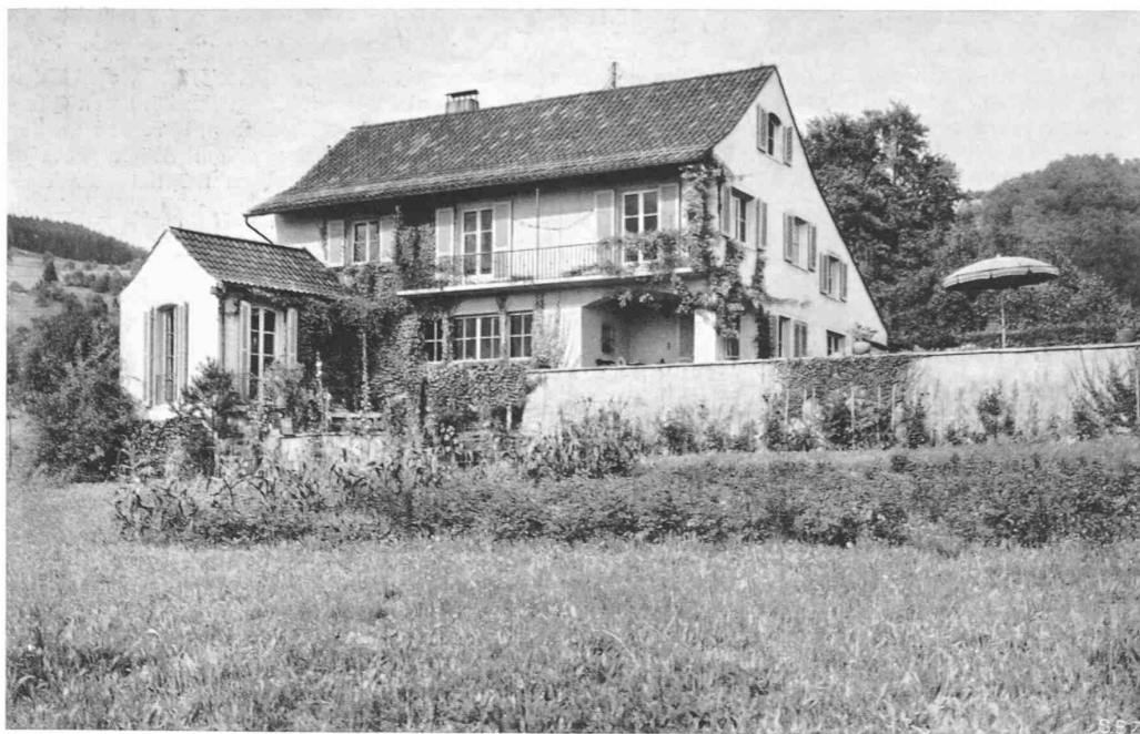
Abb. 11. Südwestfront und Südostgiebel des Hauses «Zum weiten Horizont» in Ebertswil
