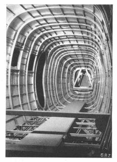
Abb. 22. Anordnung der Längs- und Querversteifungen im Leichtmetall-Schalenrumpf eines zehnplätzigen Verkehrsflugzeuges von rd. 4t Fluggewicht spruchten Hautfelde
