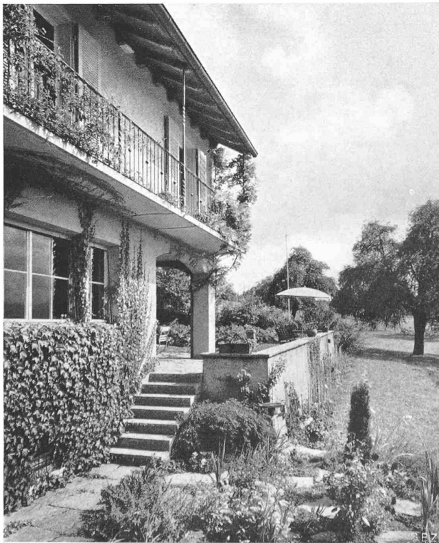
Abb. 6. Südliche Hausecke, mit oberer Gartenterrasse
