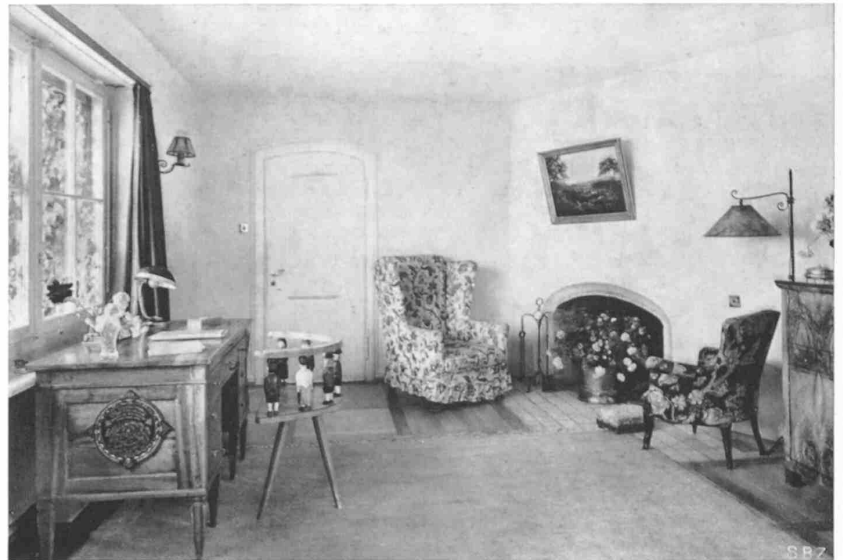
Abb. 12. Wohnstube, gegen die Gangtüre gesehen
