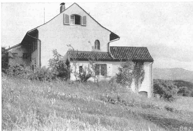
Abb. 8. Nordwestgiebel, Wetterseite des Hauses
