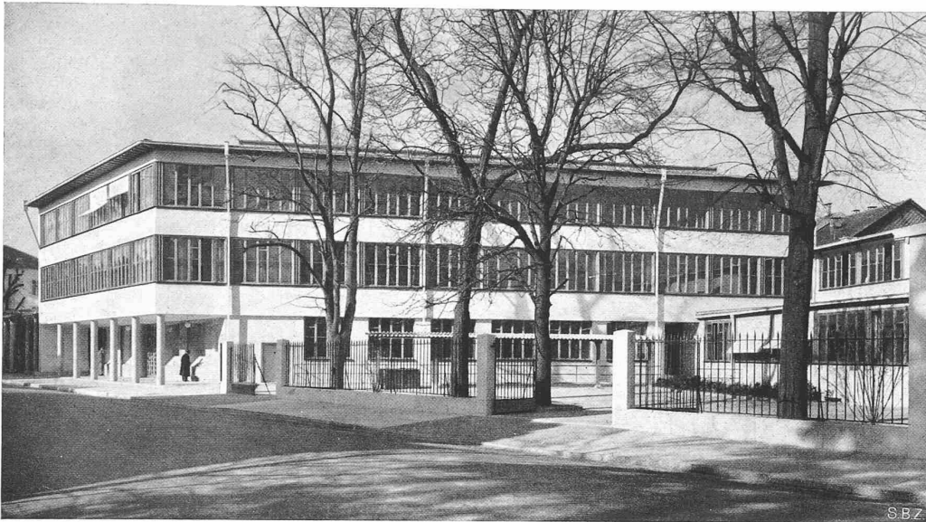
Abb. 7. Nationalzeitung, Basel. Ostansicht mit Speditionshof an der Gartenstrasse
